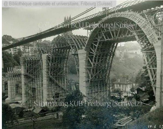
Figure 1 : Pose des cintres lors de la construction du pont de Zaehringen 1923 1
